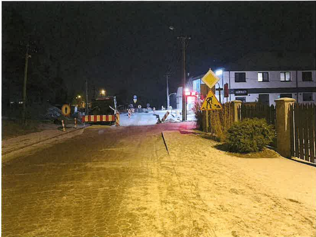
Brak wcześniejszego oznakowania, informującego o zamknięciu skrzyżowania drogi gminnej z DW254
